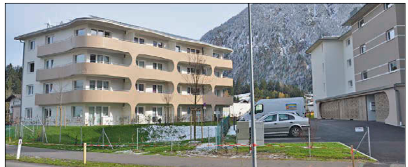
16 Monate nach Baubeginn konnten die Wohnungen in der Reuttener Gossenbrotstraße an die neuen MieterInnen übergeben werden.
