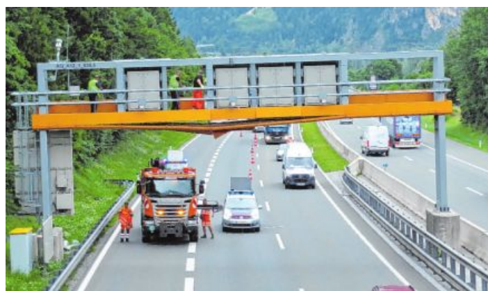
Eine Fahrbahn der A12 wurde für rund eine Stunde gesperrt, damit die Stabilität des Überkopfanzeigers überprüft werden konnte. Foto: zoom.tirol
